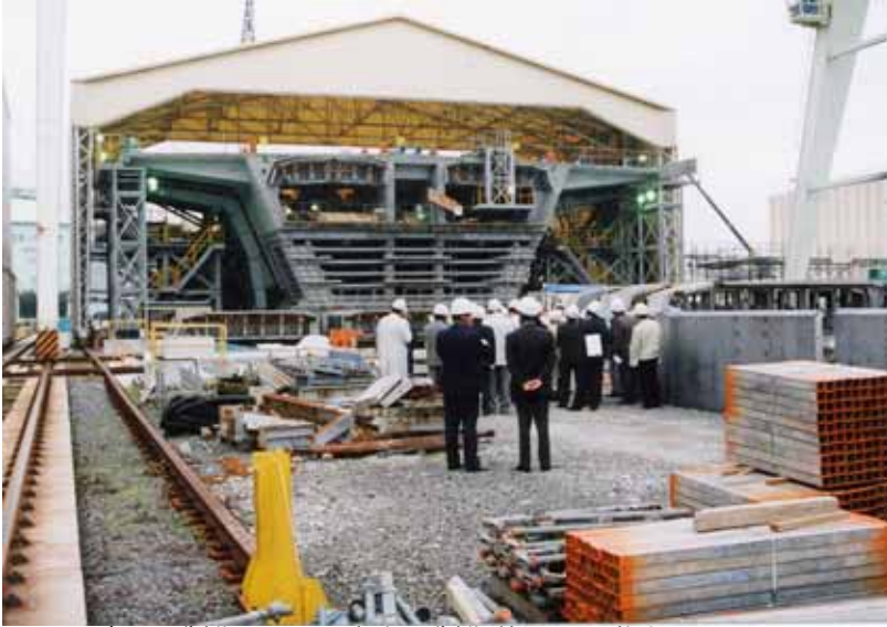
セグメント製作ヤードで実際の製作状況を見学する。
