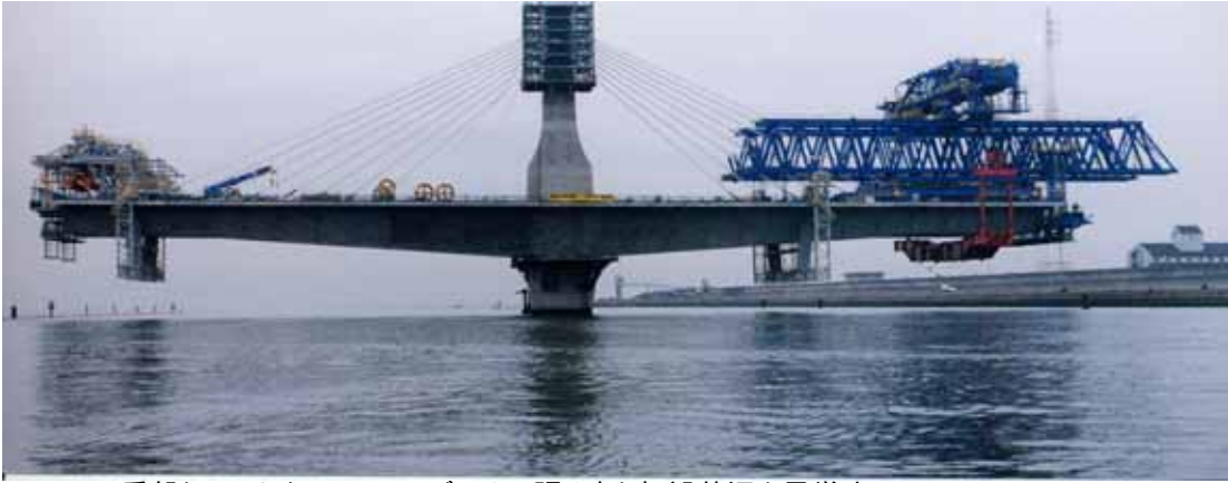
乗船してエレクションノーズによる張り出し架設状況を見学する。
