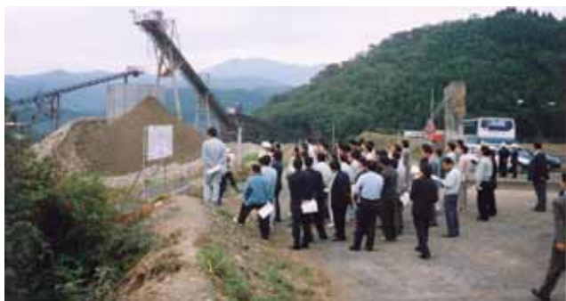
次に骨材製造工事を見学しました。
