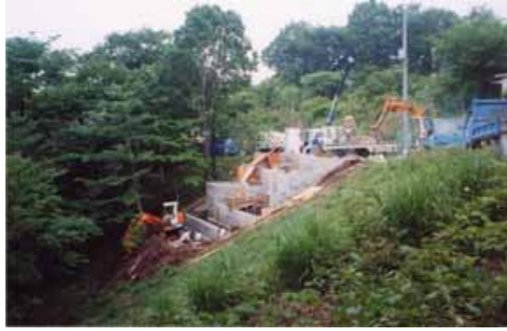
傾斜地に階段状に建築中
