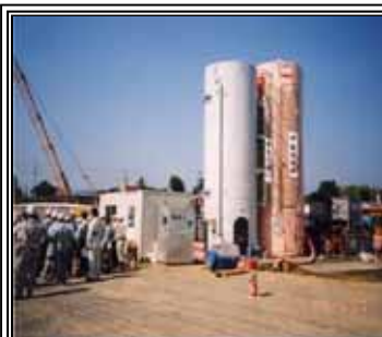
現場近くにセットされた固化混入のためのセメントサイロ
