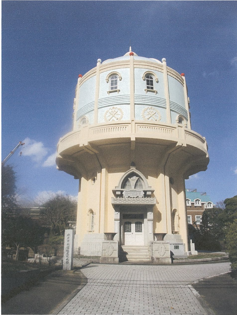
水戸市低区配水塔（昭和7年、水戸市北見町）
