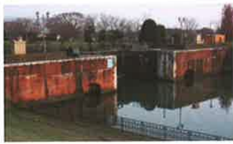
・茨城県展示作品2 横利根閘門
