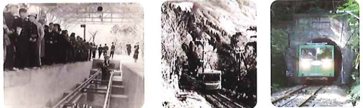
筑波山鋼索鉄道(株)提供写真
