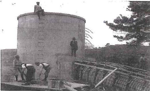
写真-5 調圧水槽（建設当時）
