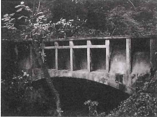
写真-4 第一水路橋
