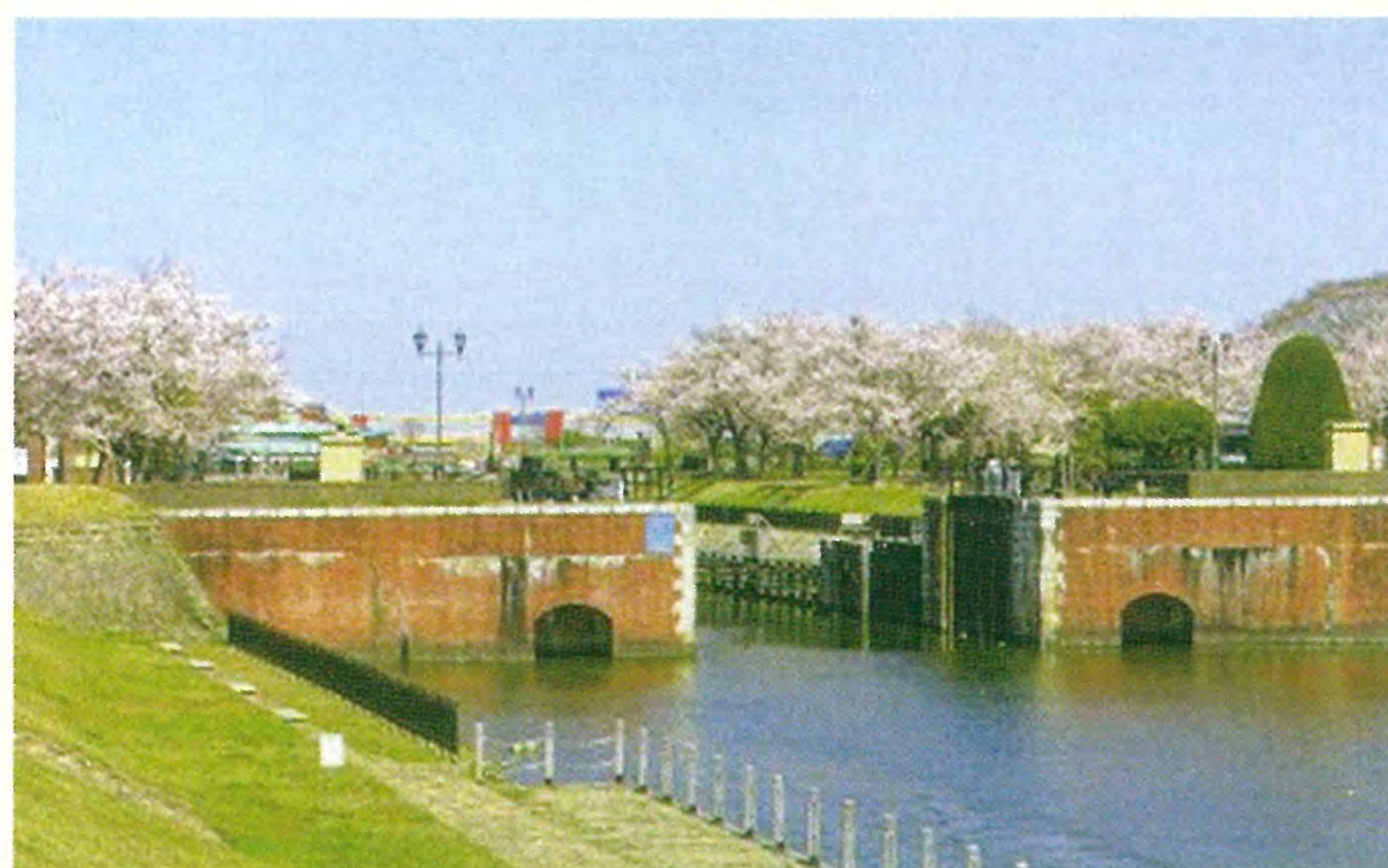
(写真3)横利根閘門 (1921 (大正10)年竣工、茨城県稲敷市) 〈明治時代から始まるレンガ造り水門・閘門の日本における到達点〉
