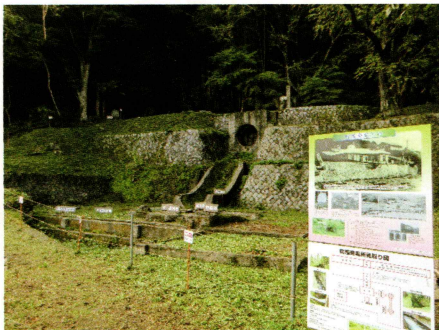
(写真4) 整備された町屋発電所の遺構
