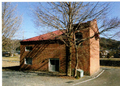
(写真2)旧町屋変電所
