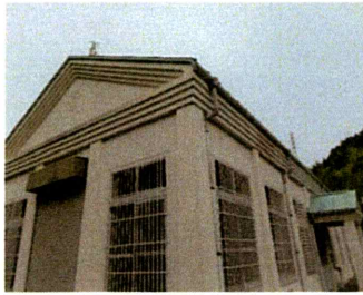
(写真3) 里川発電所建屋
