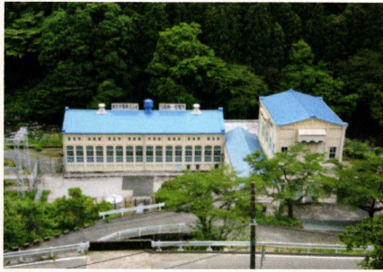
（写真1）石岡第一発電所
