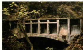
(写真3) 第一水路橋
