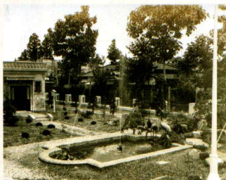
（写真4）敷地内に設置されていた噴水（「水戸市水道工事写真帳（昭和7年5月）」水戸市水道部より）
