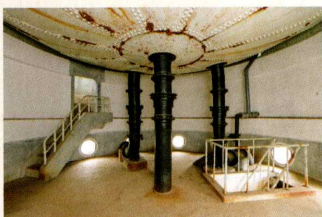
（写真3）配水塔内部、鋼製水槽底面（撮影：和氣徹也氏）
