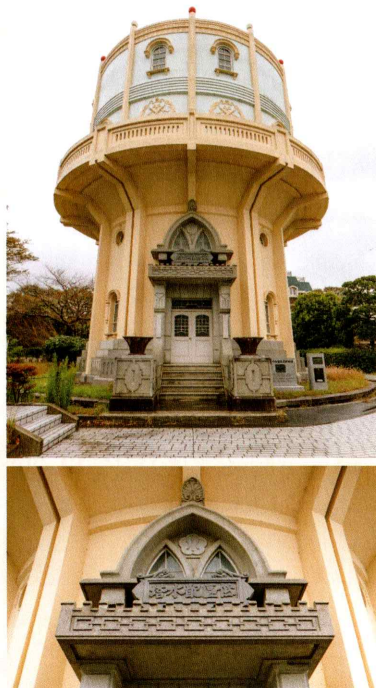
◀上(写真1)水戸市低区配水塔正面(撮影:和気徹也氏)
