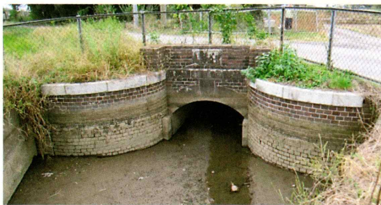
(写真1)北用水樋門
