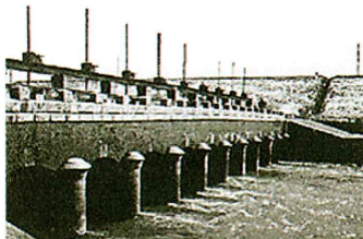
(写真2)旧豊田堰(明治34年竣工) (豊田新利根土地改良区ホームページより)
