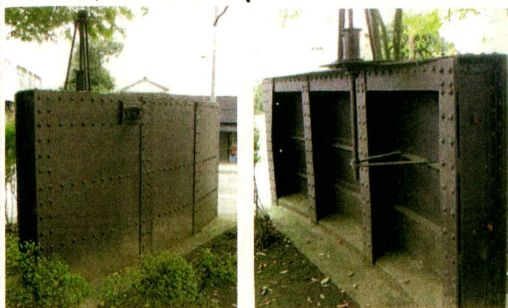
(写真4) 公園展示施設となった川口川閘門の門扉
