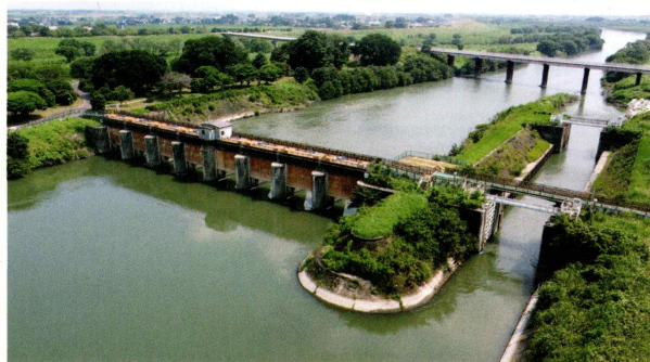
(写真3) 関宿水閘門(利根川方向からの俯瞰写真、左側:水門部、右側:閘門部)(写真提供/五霞町まちづくり戦略課)
