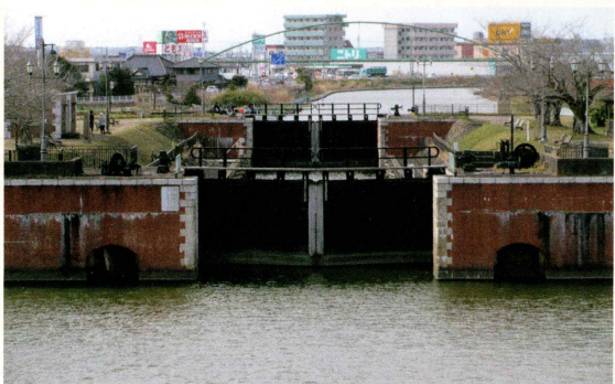
（写真1）横利根閘門（利根川方面から撮影）
