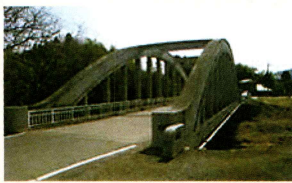
（写真4）央橋（橋軸方向から撮影）
