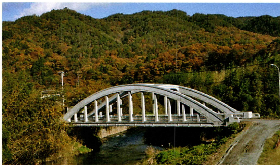
（写真3）央橋（全景）
