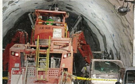
ロックボルト打込み
