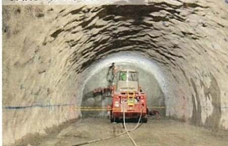
掘削（火薬装てん）
