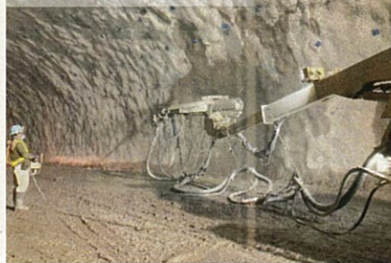
吹付コンクリート
