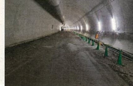
覆工コンクリート
