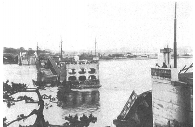
写真12 昭和13年6月の洪水で墜落した海門橋
