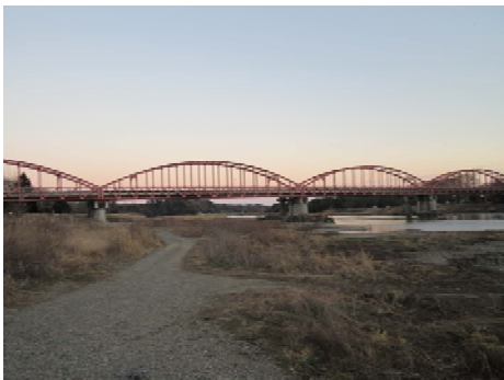
御前山大橋（昭和 24 年竣工、常陸大宮市）
