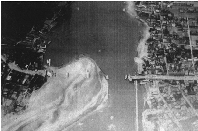
写真11 海門橋の落橋と万衛門川
