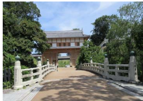
大手橋（昭和 10 年竣工、水戸市）
