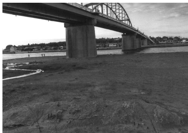
写真 17 第４代目 海門橋基礎の名残
