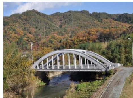
央橋（昭和 12 年竣工、常陸太田市）
