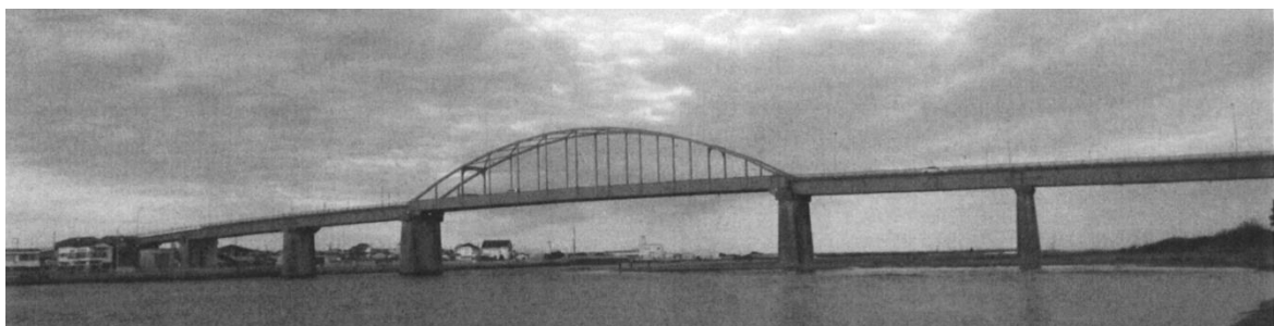
写真2 現在の第5代海門橋
