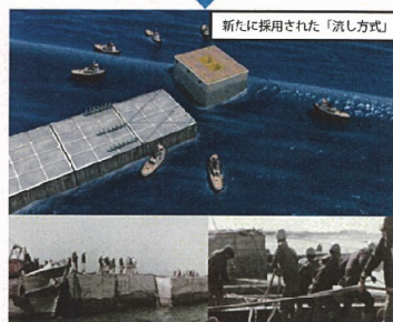
写真2 ケーソン掘付け工法
