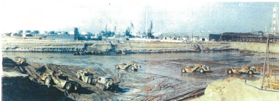
中央航路陸上掘削（モータスクレーパーによる掘削）
