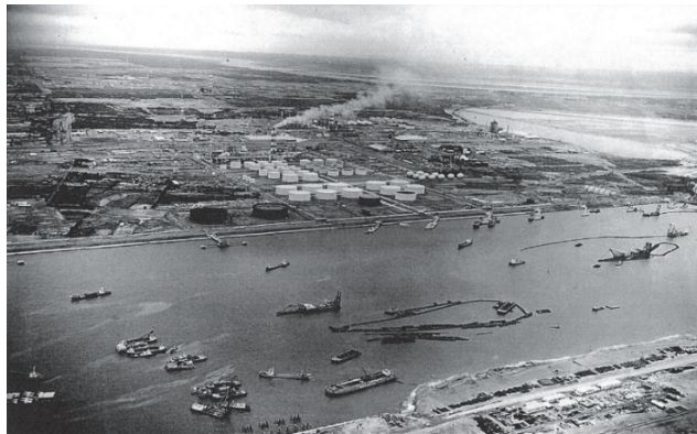
海上掘削の状況（岸壁に隣接し製鉄所の建設が進められている）
