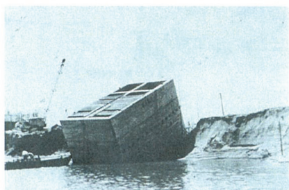
砂上で作成したケーソンの進水
