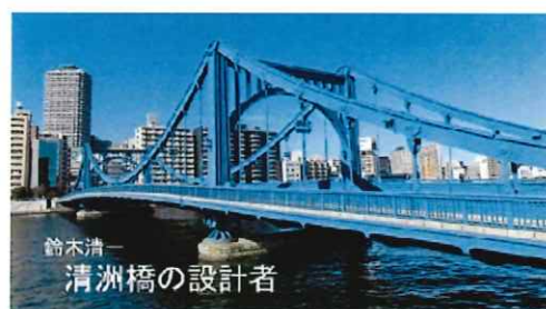
帝都復興事業隅田川架橋「清洲橋」現在重要文化財
