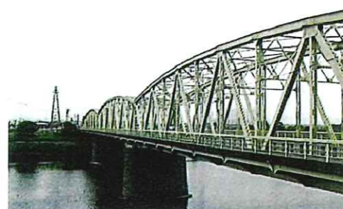
(写真5) 旧水府橋 (1932 (昭和7) 年竣工、茨城県水戸市)
