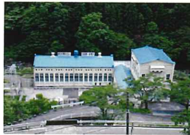
(写真1) 石岡第一発電所
