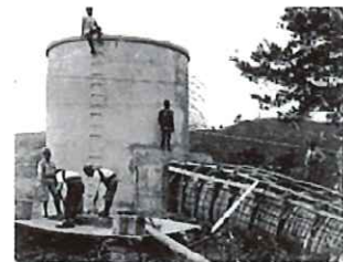
(写真4) 工事中のサージタンク (東京発電株式会社所蔵)
