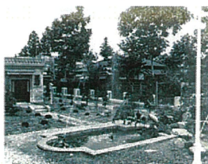
(写真4) 敷地内に設置されていた噴水(「水戸市水道工事写真帳(昭和7年5月)」水戸市水道部より)
