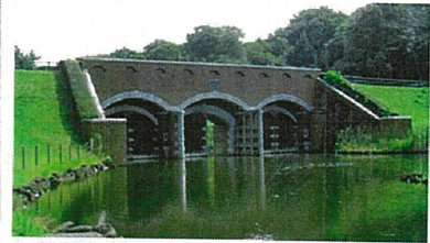
(写真2) 部材の一部を使い復元された反町閘門 (茨城県自然博物館園庭)
