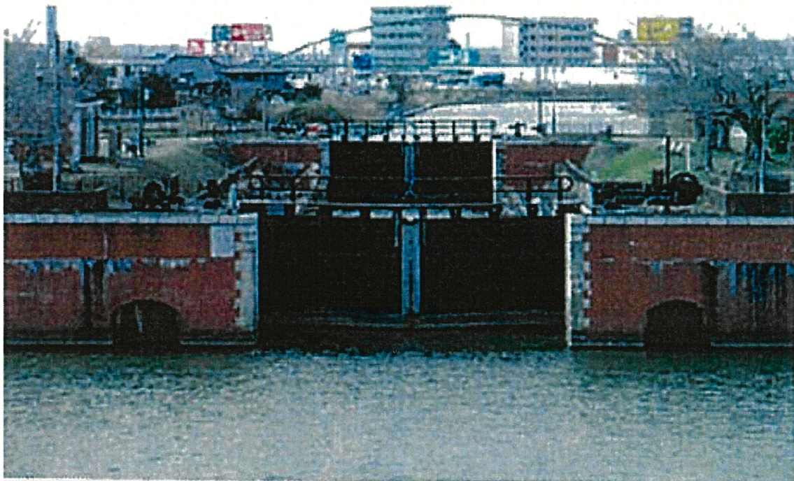
横利根水閘門（稲敷市、1921(大正 10)年竣工）
