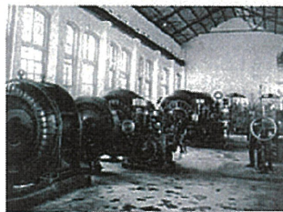
(写真5)竣工時の発電所内
