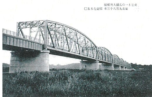
旧大利根橋（昭和5年竣工）
