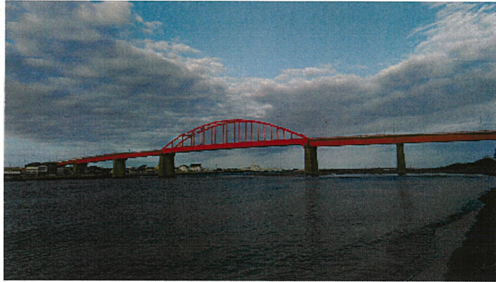
第5代海門橋（現橋、昭和34年竣工、鋼製ランガーアーチ橋）
