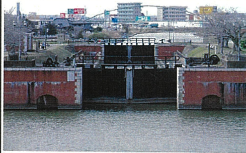
(写真1) 横利根閘門(利根川方面から撮影)
