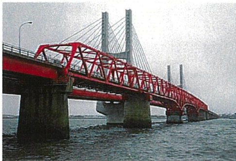
旧銚子大橋（昭和37年竣工、鋼製トラス橋）
