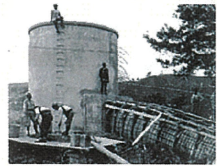
(写真4)工事中のサージタンク
