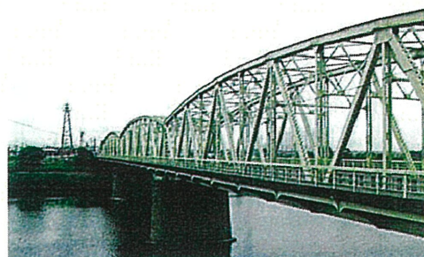
（写真5）旧水府橋（1932（昭和7）年竣工、茨城県水戸市） 〈美しいシルエットの円弧トラス橋。那珂川の改修・大型車交通量の増加のため2013（平成25）年架け替え。橋詰に部材の一部を利用したモニュメントを設置〉
