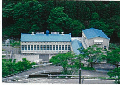
(写真1)石岡第一発電所
